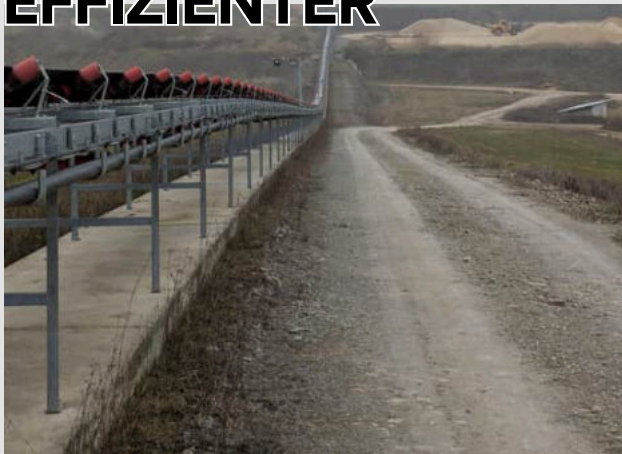
Landbandanlage im KW Schkölen
